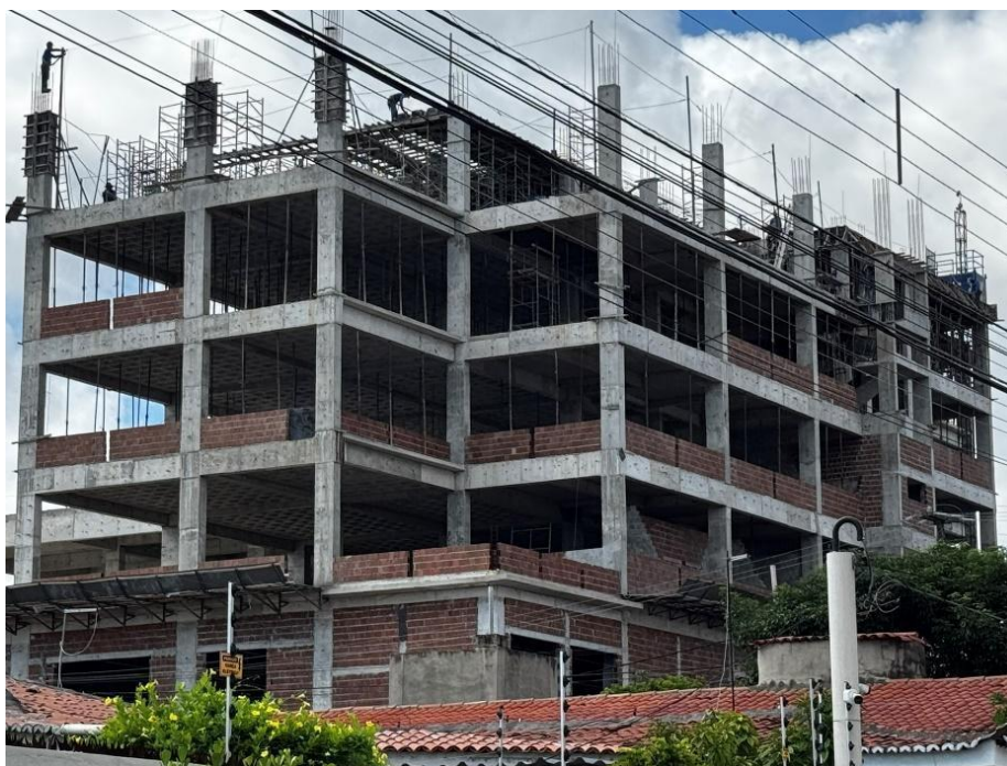
Figura 6. Montagem e concretagem dos pilares do terceiro pavimento.
