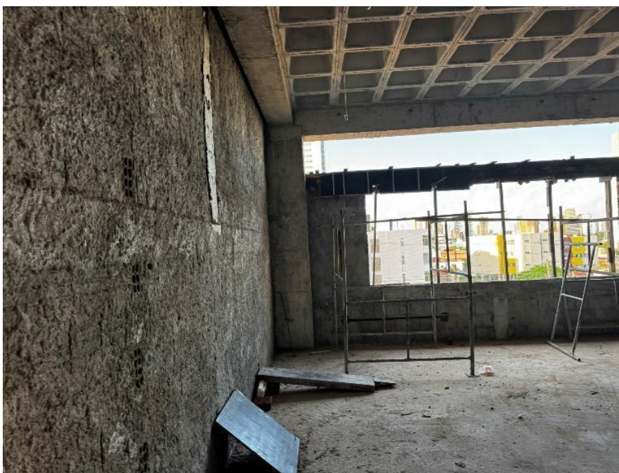
Figura 13. Chapisco aplicado nas paredes internas.
