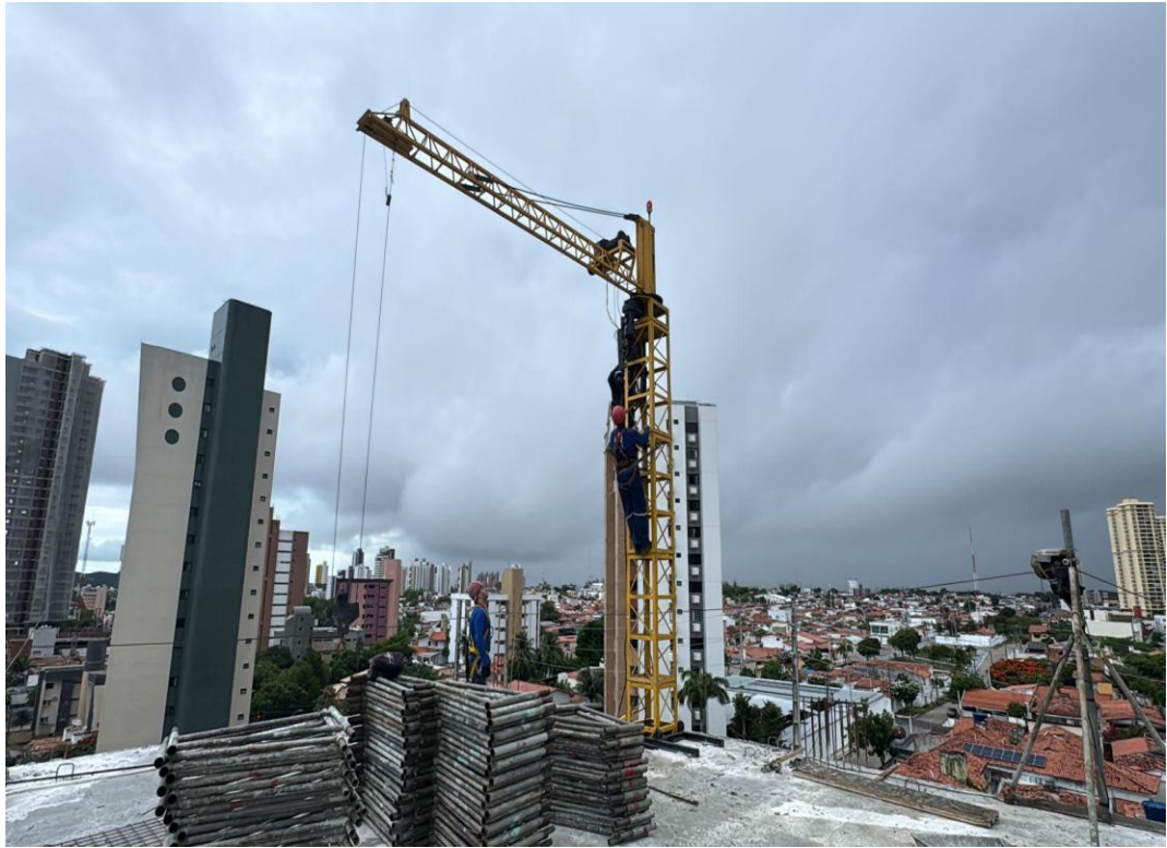
Figura 3. Instalação da torre grua.
