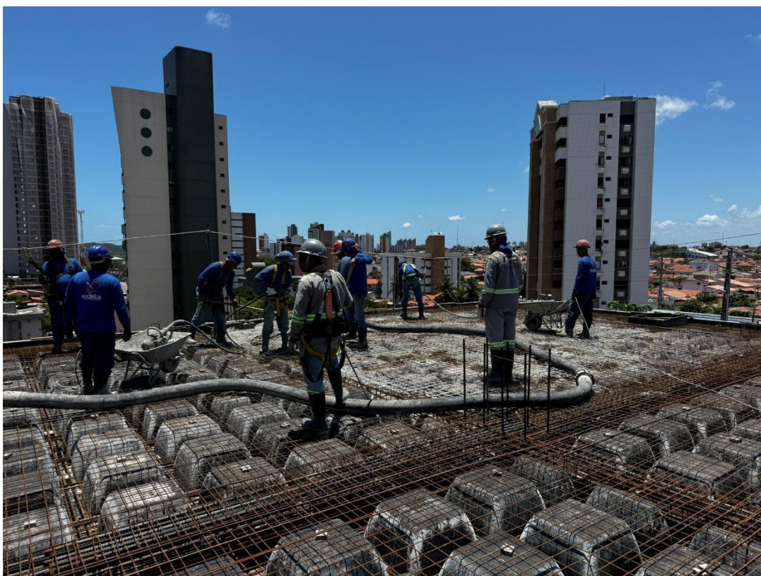
Figura 7. Concretagem da laje de cobertura do terceiro pavimento.
