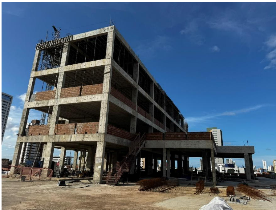
Figura 5. Visão da fachada sul com a concretagem da primeira metade da laje de cobertura do terceiro pavimento.
