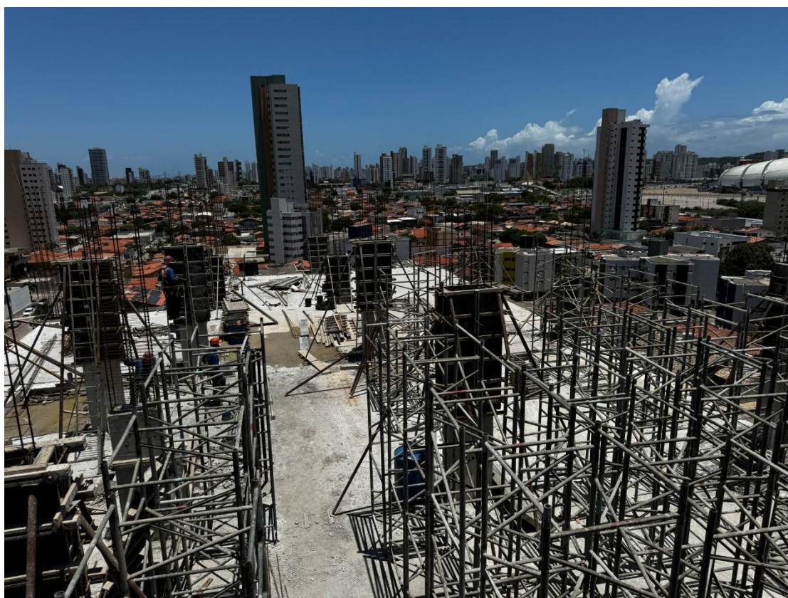
Figura 8. Concretagem dos pilares do terceiro pavimento.
