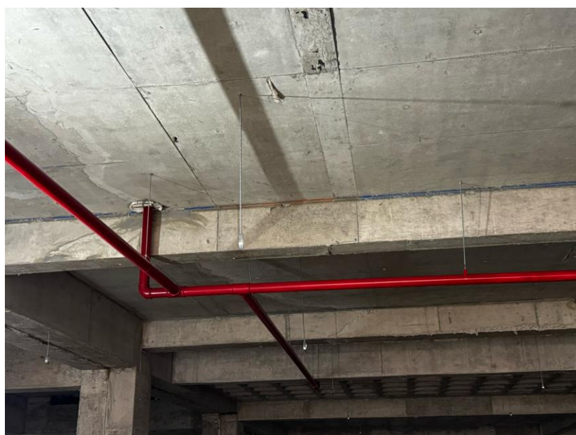
Figura 16. Instalação das tubulações de aço galvanizado de hidrantes no segundo semi enterrado.
