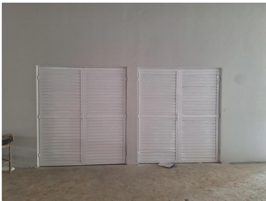
Figura 14. Portas instaladas nas salas do nobreak e de quadros..
