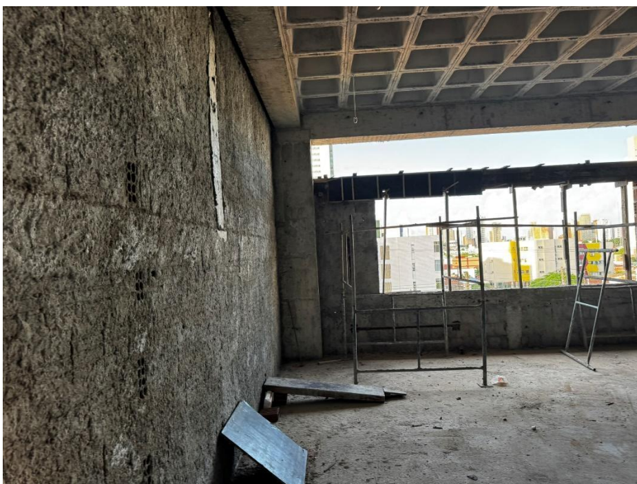
Figura 11. Execução de vergas e pilares de travamento nas alvenarias.
