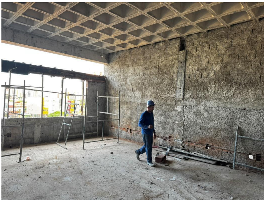
Figura 10. Execução de vergas e pilares de travamento nas alvenarias.
