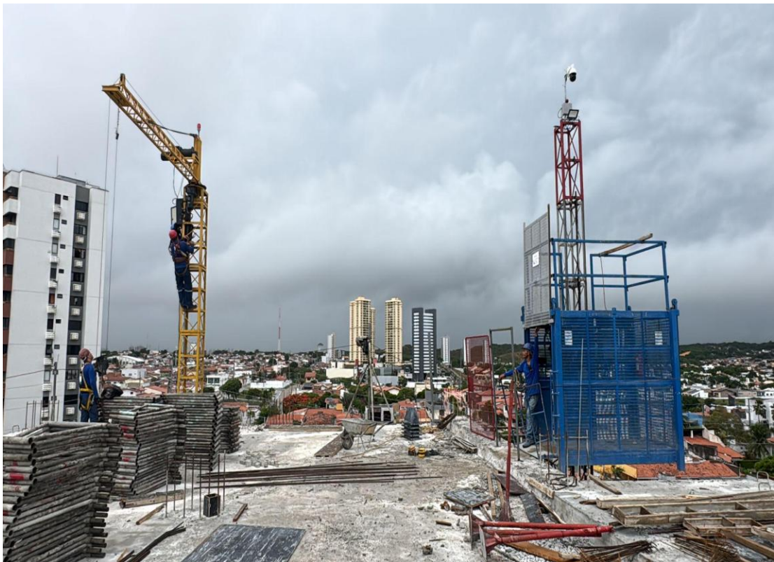
Figura 4. Visão da Grua e Cremalheira na laje de piso do quarto pavimento.
