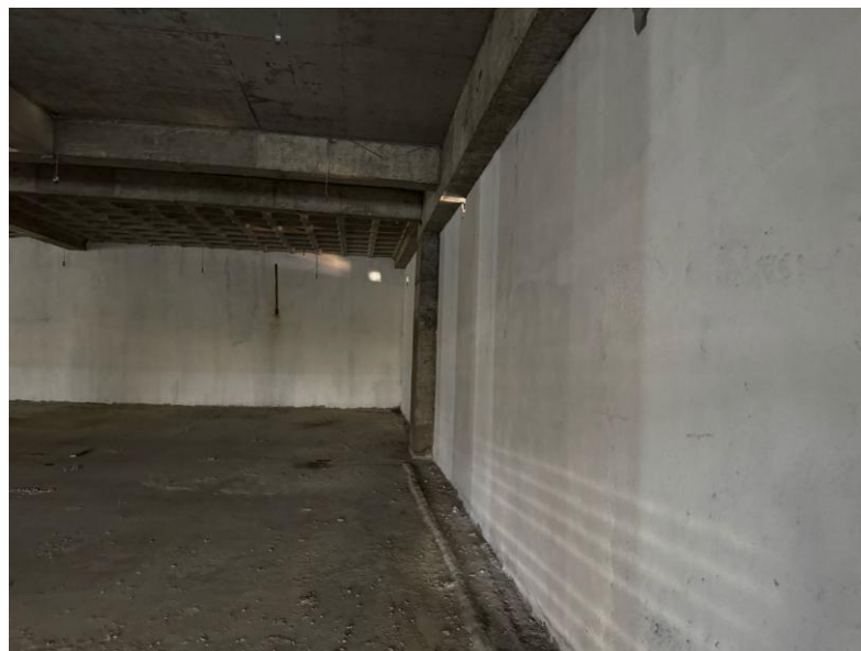
Figura 15. Aplicação de selador em paredes.
