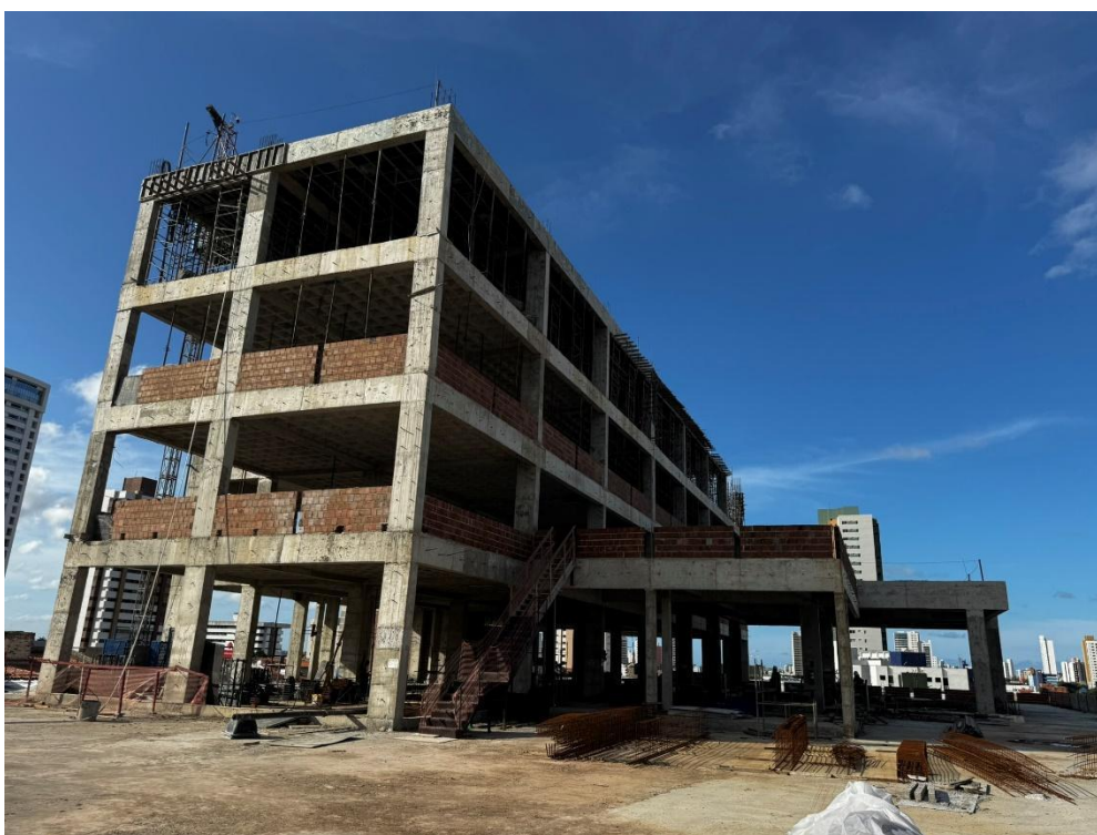
Figura 1. Visão geral da obra.
